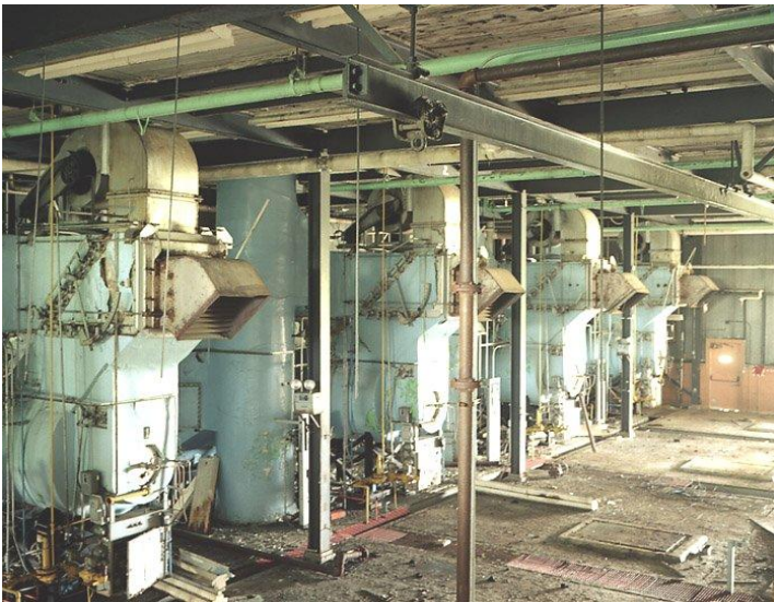
Old HRSG Boilers at Pinetree station
