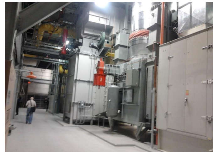
Solar Titan 130 with HRSG (2012)
